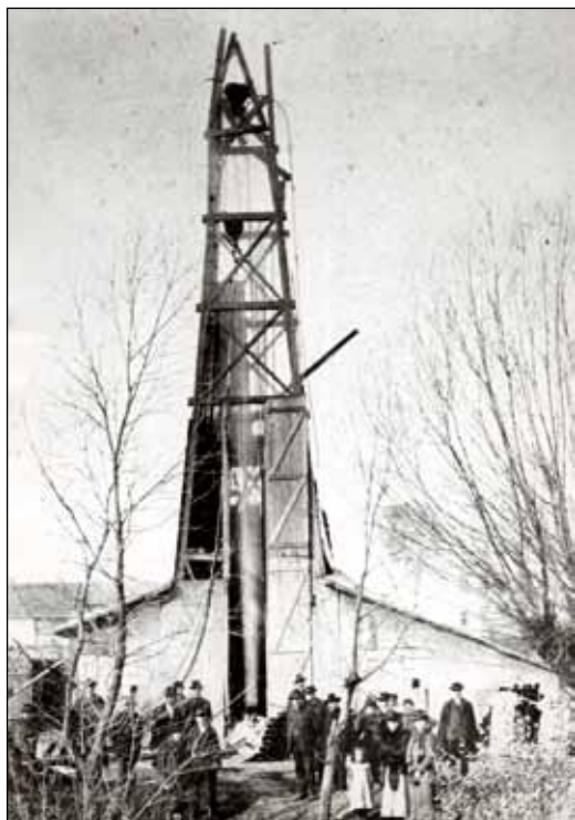
Częściowo zniszczona w 1908 r. górna część wieży wiertniczej; widoczny również wydobywający się z otworu strumień zgazowanej solanki. Fotografia ze zbiorów Tadeusza Kopoczka
